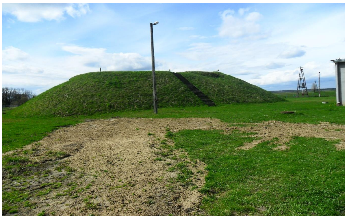
Ryc. Ujęcie wody w Starym Dzikowie
