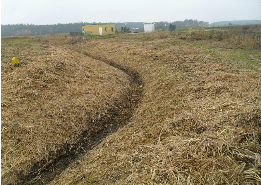
Ryc. Urządzenie wodne w m. Cieszanów
