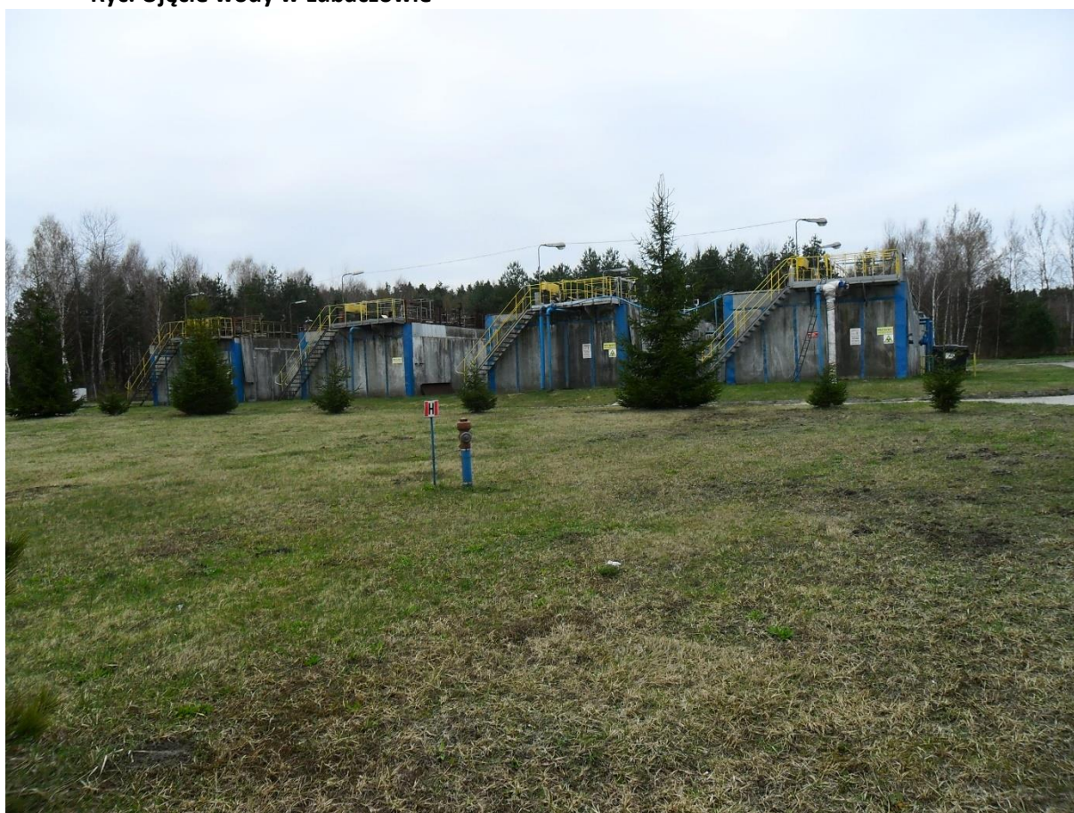
Ryc. Ujęcie wody w Lubaczowie
