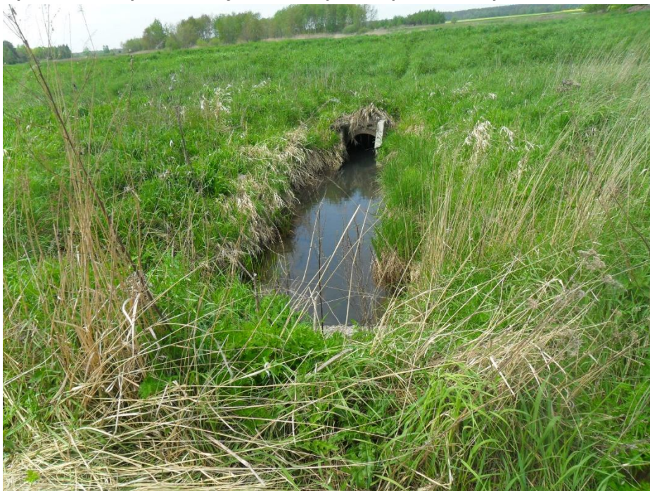
Rys. Obiekt – syfon w obrębie wałów przeciwpowodziowych w Ułazowie
