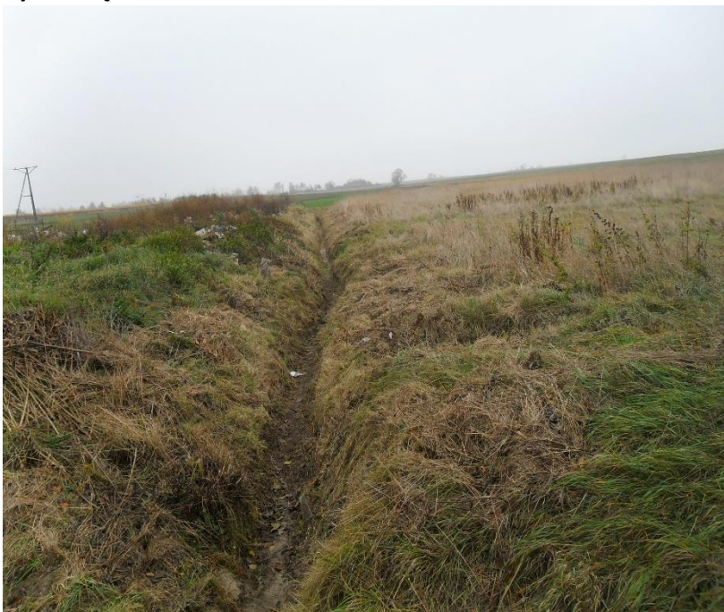
Ryc. Urządzenie wodne Dachnów-Czereśnie
