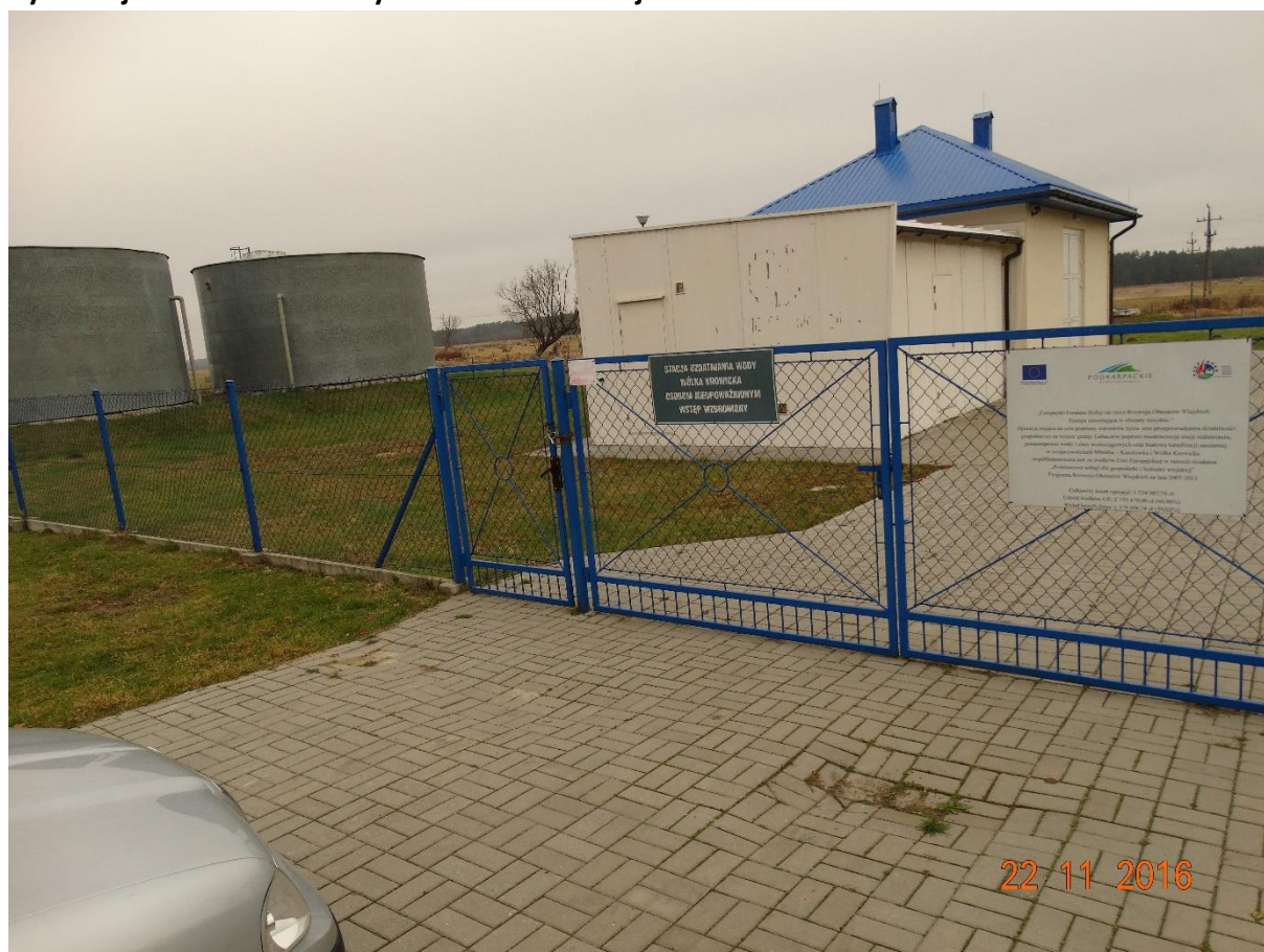
Rys. Stacja Uzdatniania Wody w Wólce Krowickiej
