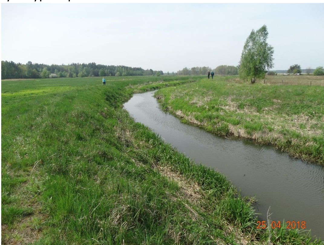
Ryc. Wały przeciwpowodziowe w Ułazowie
