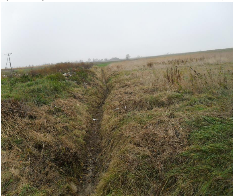
Ryc. 38 Urządzenie wodne rów B1 Dachnów-Czereśnie, 2015r., (Źródło: własne)
