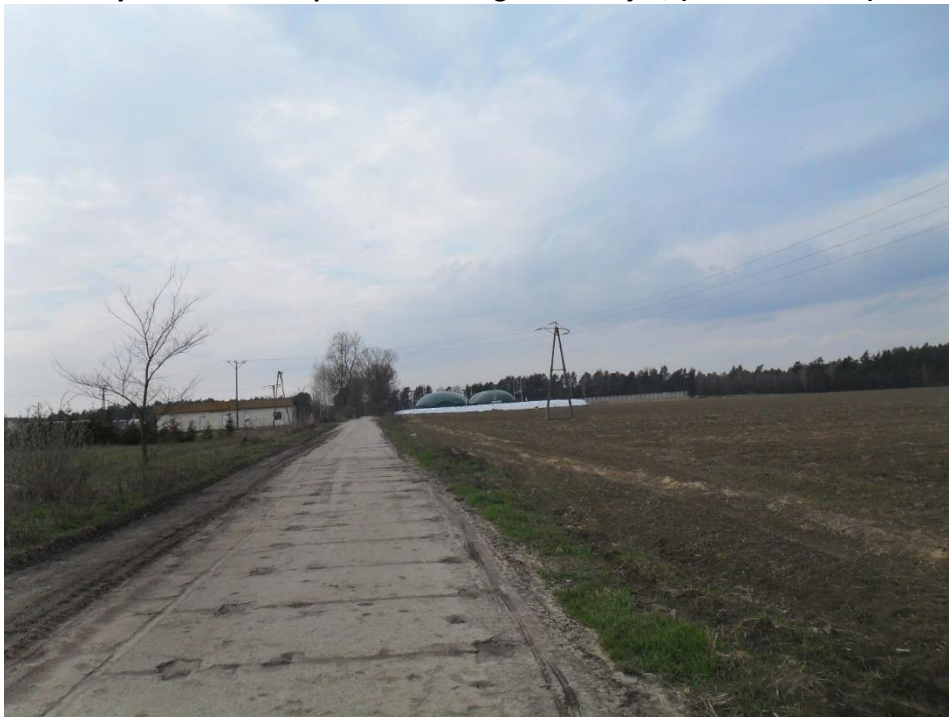
Ryc. 65 Elektrociepłownia na biogaz w Gorajcu, (Źródło: własne)
