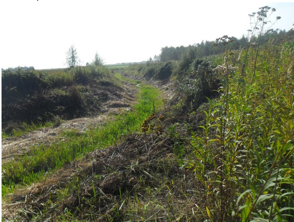
Ryc. 43 Urządzenie wodne rów 1-3, wpadający do rowu głównego L-26 na obiekcie Kobylnica, 2014r. (Źródło: własne)
