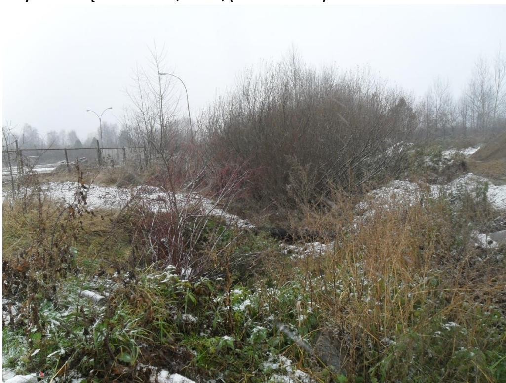
Ryc. 46 Stan urządzenia wodnego nie objętego konserwacją melioracyjną – rów położony koło „Polmozbytu” w obrębie Lubaczów, 2014r., (Źródło: własne)
