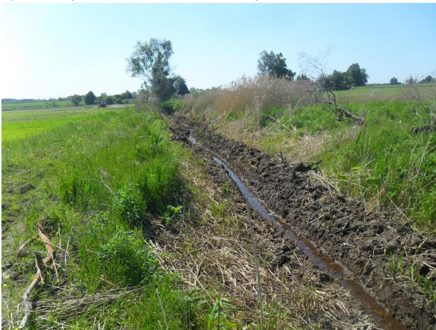
Ryc. 42 Urządzenie wodne na obiekcie Kobylnica, 2014r. (Źródło: własne)
