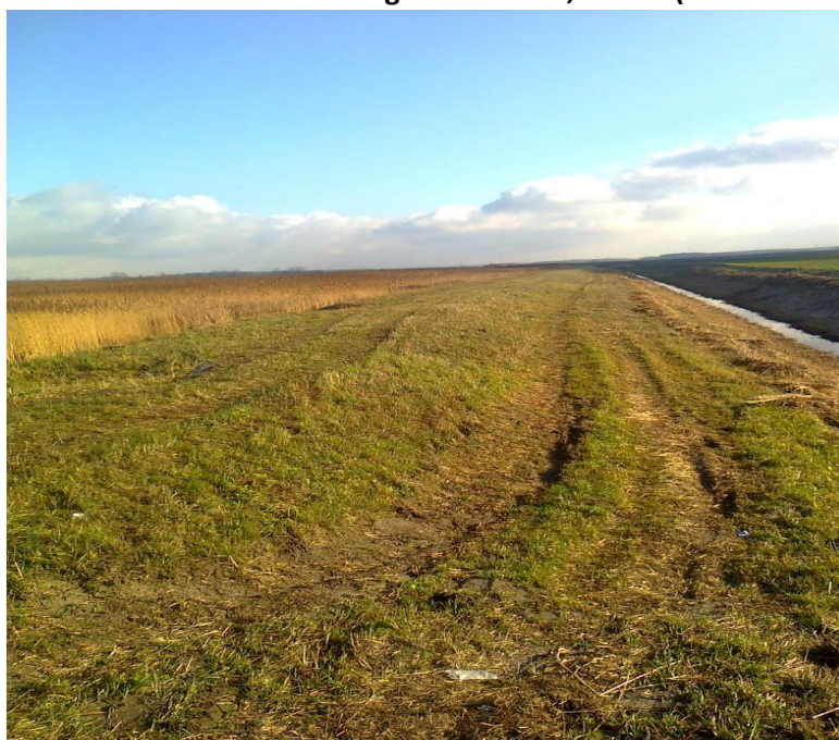
Ryc. 29 Groble zbiornika wodnego w Lublińcu, 2015r. (Źródło: własne)
