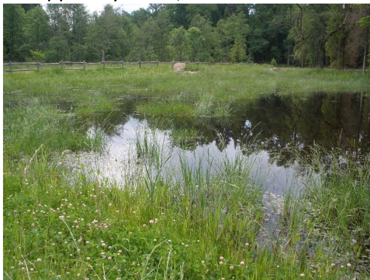
Ryc. 11 Zbiornik p.pożarowy w Załużu, Nadleśnictwo Lubaczów
