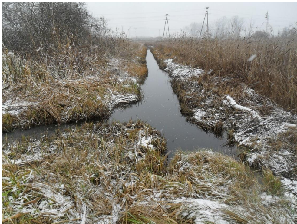
Ryc. 44 Urządzenia wodne A1 i A2 na obiekcie Lubaczów – CPN (koło rzeki Sołotwa w Lubaczowie), 2014r. (Źródło: własne)
